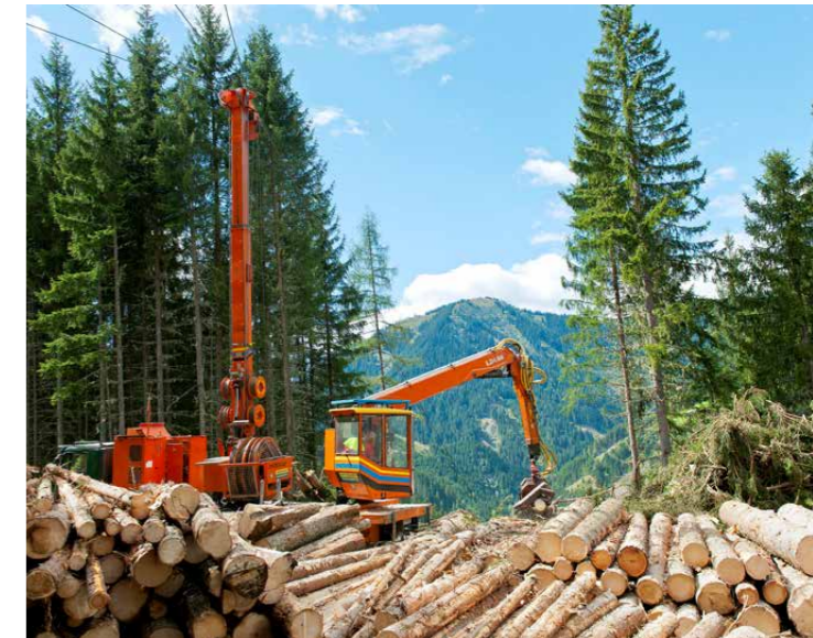
Holzarbeiten mit Seilkran
